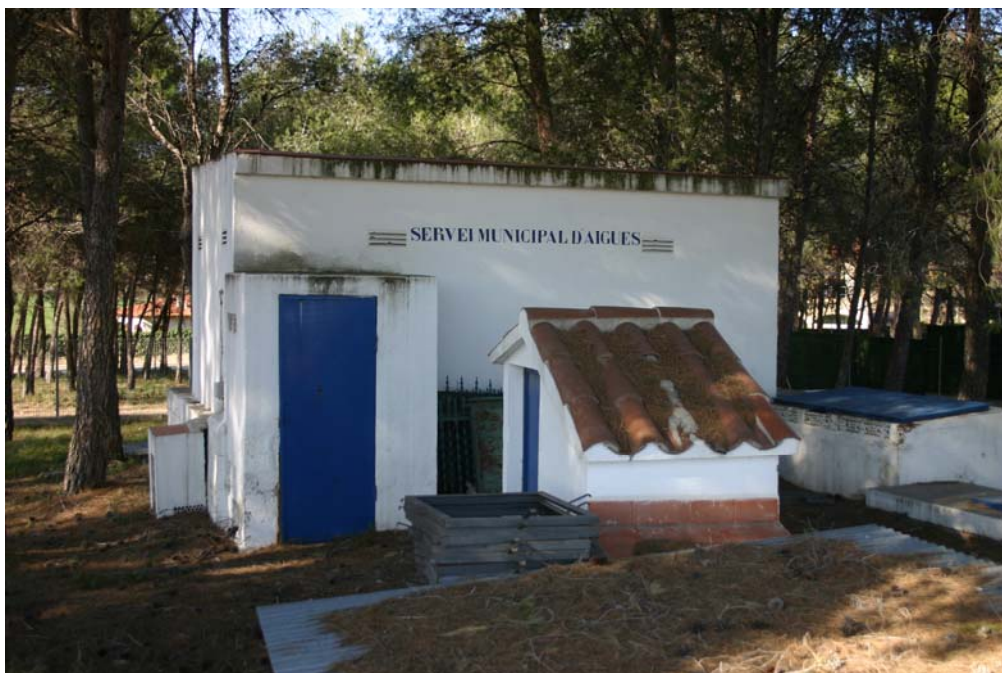
Foto n°98. Imatge d'una de les instal·lacions de pous i bombament situada als Boscos del Priorat
